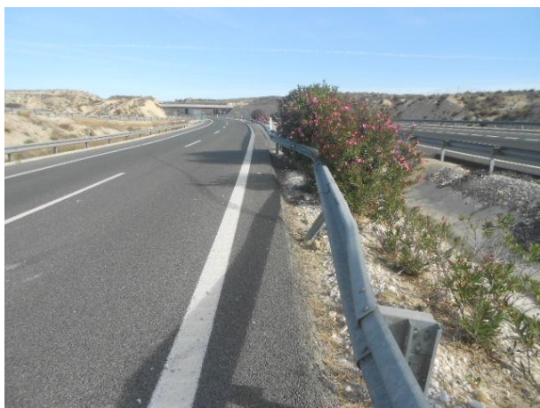
Figura 1. Golpe en la barrera metálica de la mediana.
