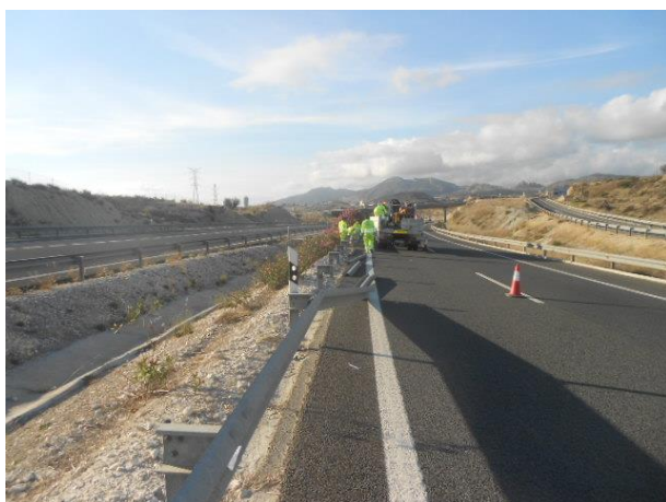
Figura 3. Desmontaje de la barrera golpeada
