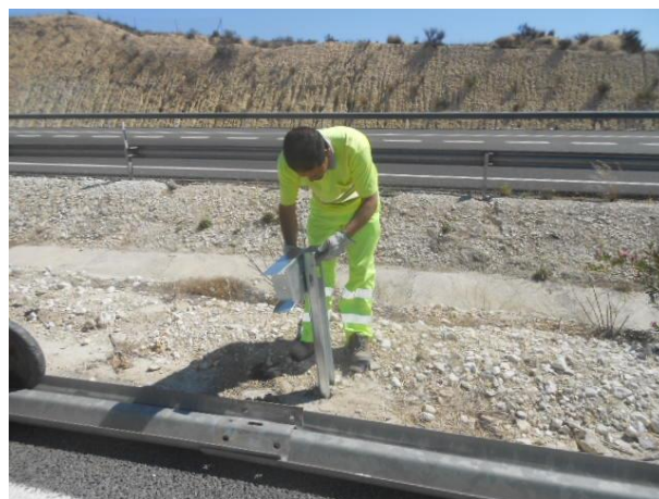
Figura 6. Montaje de separadores
