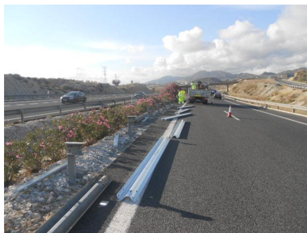
Figura 4. Extendido de la barrera sobre el suelo para marcar la posición definitiva de los postes
