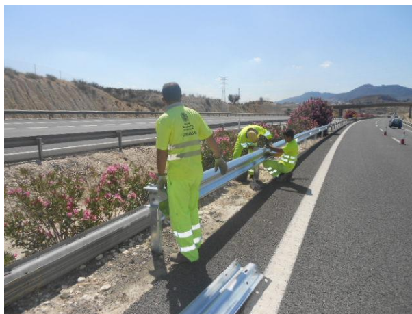
Figura 7. Montaje de la valla
