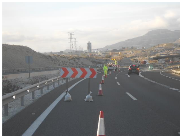
Figura 2. Señalización de la zona donde se va actuar según la Norma de Carreteras 8.3.- IC
